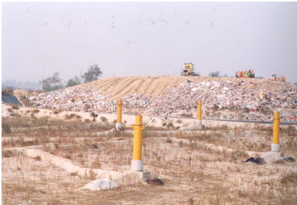
Bild 5: Gasbrunnen für die horizontale Basisabsaugung im Jahre 2001
