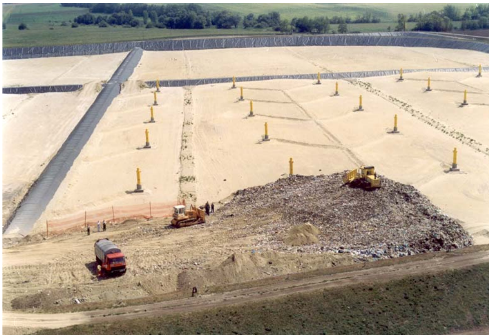
Bild 4: Luftbild während des ersten Müllleinbaus im Jahre 2000 mit den Gasbrunnen
