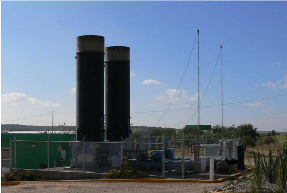
**Abbildung 2: zwei „Fackeln“ zur Gasbeseitigung auf der Deponie San Nicolás**
