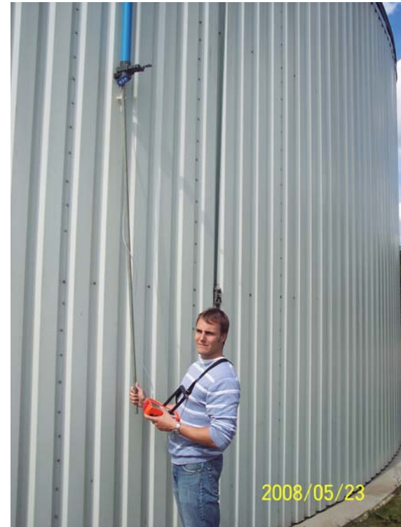
Abb.7 Abblasöffnung Tragluftdach vom Fermenter [DAS-IB GmbH, 2008]
