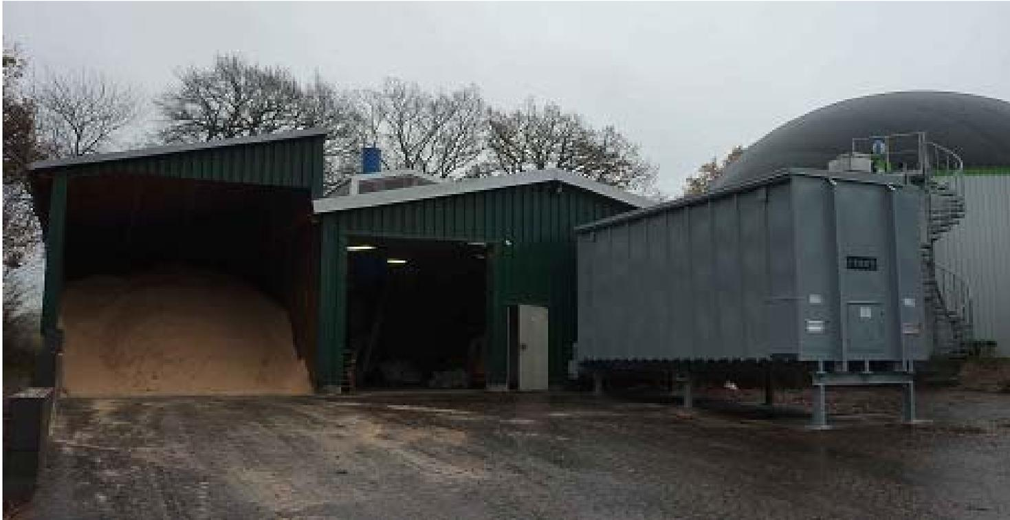
Foto: Lager für Rohsägespäne; Halle mit Trockner, Pelletierer und Produktlager, Eintragungssystem als Schubbodencontainer
