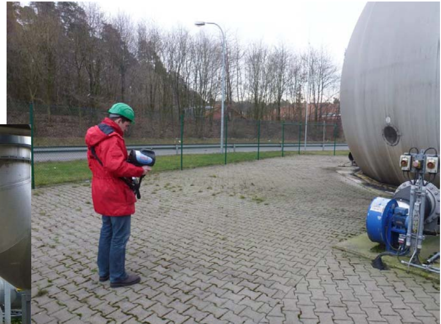
Abb. 4: Leckagesuche an einem Gasspeicher
