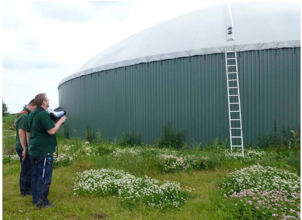
Abb. 3: Dichtigkeitskontrolle eines Tragluftdaches einer BGA
