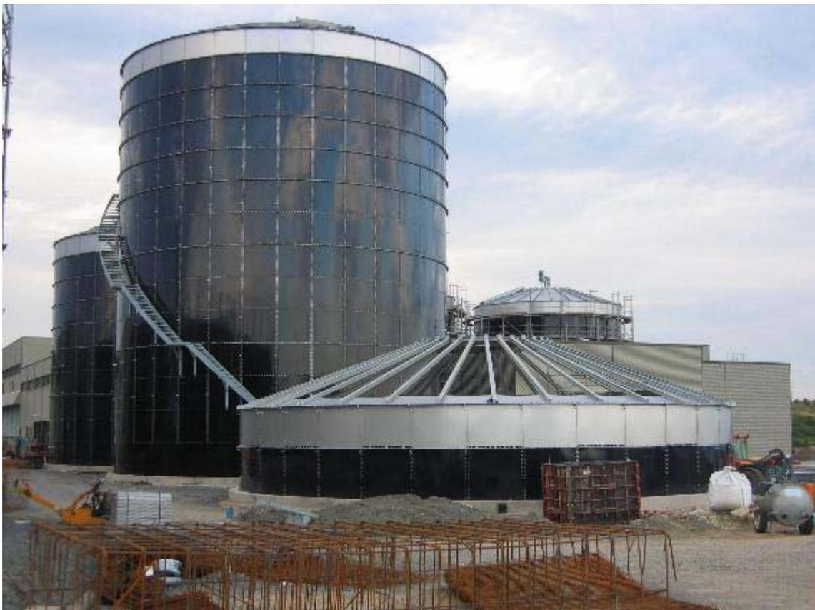
Figure 1. Die drei Fermenter während der Bauphase (Abfallzweckverband Südniedersachsen, 2005).
